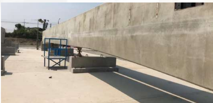
รูปที่ 3 การวาง GWB บนจุดรองรับเพื่อปลดแรงดึงในลวดอัดแรง
