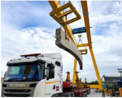
รูปที่ 1 CURVE GUIDEWAY BEAM สายสีเขียวเหลือง
