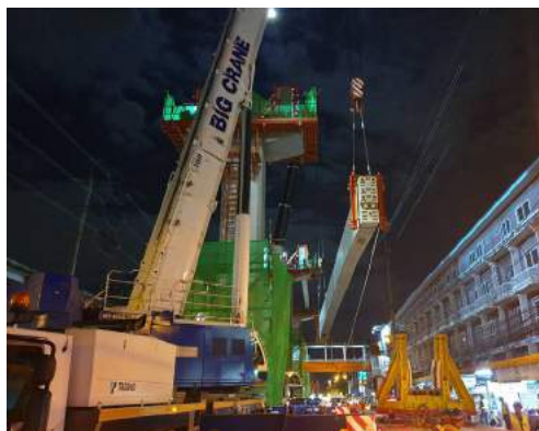
แสดงขั้นตอนการติดตั้ง Guideway Beam (2)
