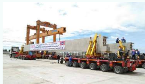
การจัดเตรียม Guideway Beam ก่อนทำการขนส่ง
