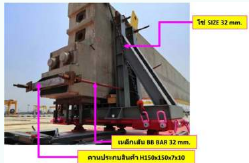
การจัดตรึง แผ่น Precast Concrete Segment กับพาหนะขนส่ง
