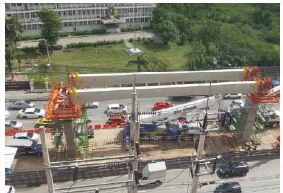
แสดงขั้นตอนการติดตั้ง Guideway Beam (3)
