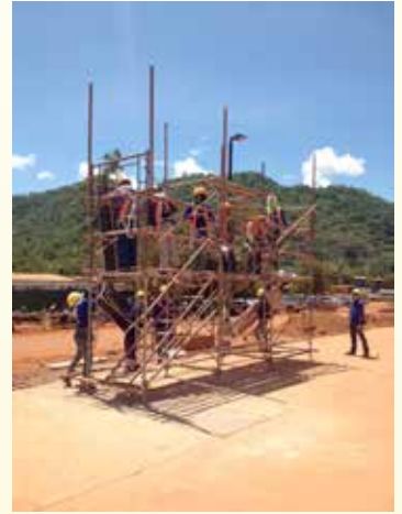
การฝึกอบรมช่างติดตั้งนั่งร้าน เพื่อสร้างมาตรฐาน
