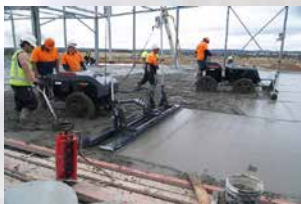
การทำงานของเครื่อง Laser Screed
