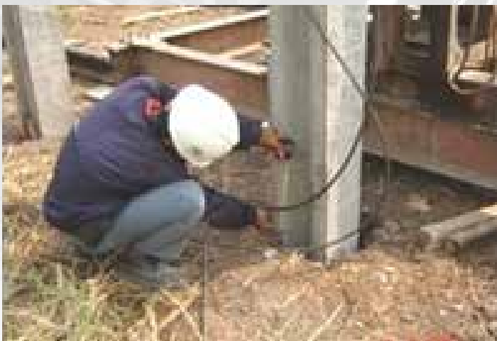
ภาพที่ 2 แสดงการเก็บค่าระยะเสาเข็มเพื่อบันทึก Blow Count
