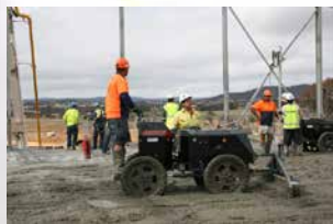
การทำงานของเครื่อง Power Rake
