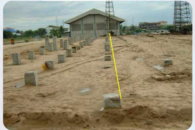
ภาพที่ 1 แสดงการเยื้องศูนย์ของเสาเข็มตามแนวราบ (Horizontal Deviation)
