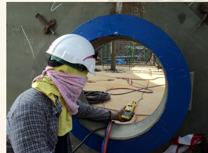
ผู้ควบคุมงานตรวจวัดสภาพบรรยากาศ ก่อนเข้าไปทำงาน
