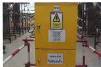
การติดป้ายสัญลักษณ์เตือนอันตรายจากกระแสไฟฟ้า
