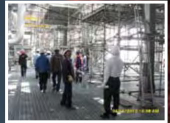
ตรวจสอบการติดตั้งนั่งร้าน
